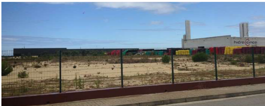
Ilustração 6: Edifício da Eurocast, visto de Sul.
