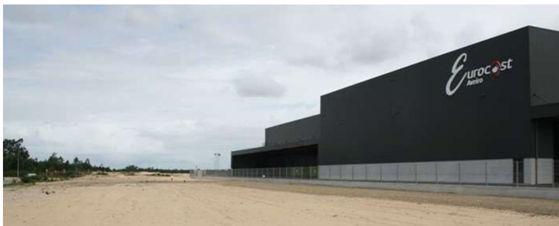
Fig. 3: Edifício da Eurocast, visto de SO.
